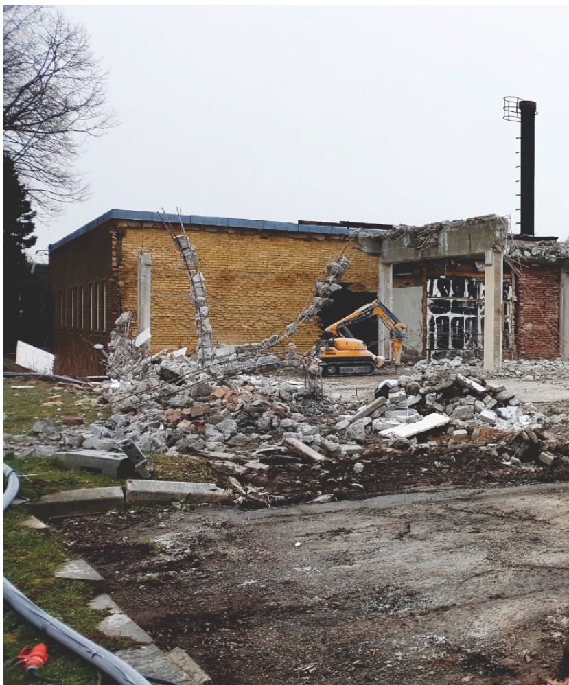
Den gamle brugs i Asminderød under nedrivning i foråret 2019
