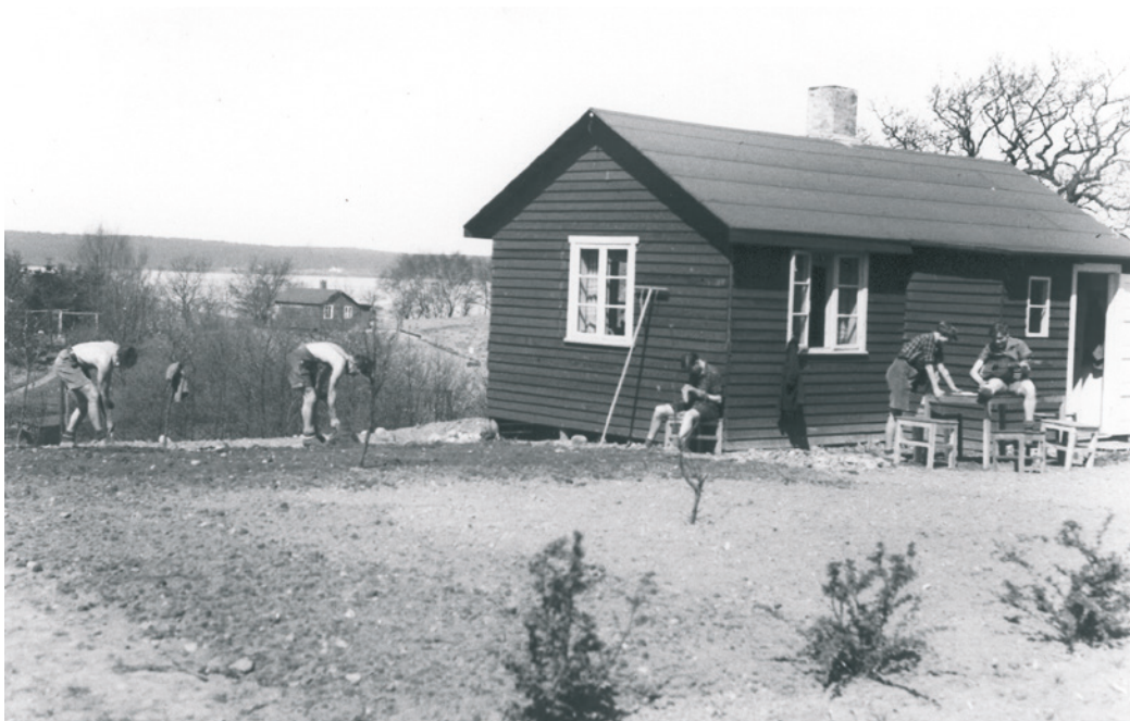
KØKKENHAVE ANLÆGGES VED ET AF COOPERATIVETS HUSE.
