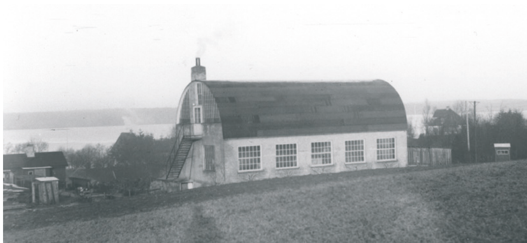
FABRIKSBYGNINGEN SOM DEN SÅ UD LIGE EFTER FULDFØRELSEN. DEN BRÆNDTE I 1941 OG BLEV GENOPFØRT, MEN UDEN DET KARAKTERISTISKE HVÆLVEDE TAG.
