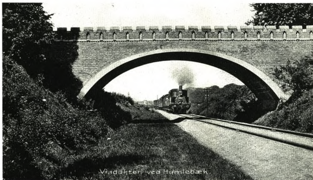
Den tidligere viadukt ved Krogerup Allé. Bemærk den flotte Monierbue med rødt murværk og hugget granit. Billedet er fra 1908. Broen blev nedrevet og erstattet med en ny i 1981 i forbindelse med Kystbanens elektrificering.
