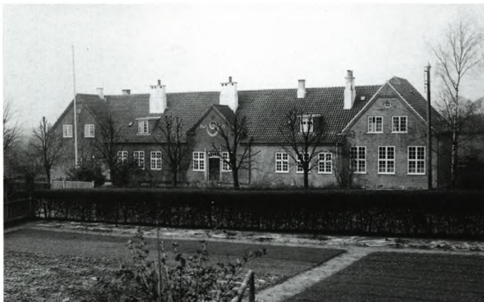
Skolens østfacade efter tilbygningen 1929
