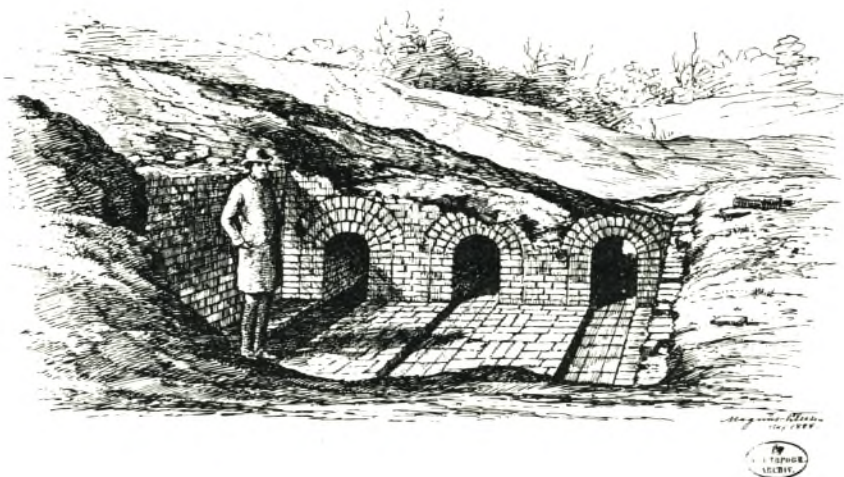
Fig. 1. Tegning af Magnus Petersen fra 1888 af udgravning i en almindelig åben teglovn fra omegnen af Svendborg. Personen står inde i den tomte oven, der har tre rundbuede indfyringsåbninger og lave bænke til opstabling af sten.
