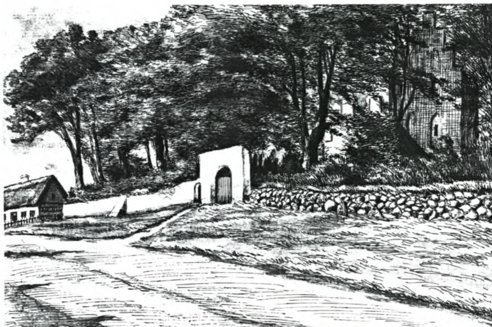
Grønholt kirke, gærdet med portal mod Grønboltvej
