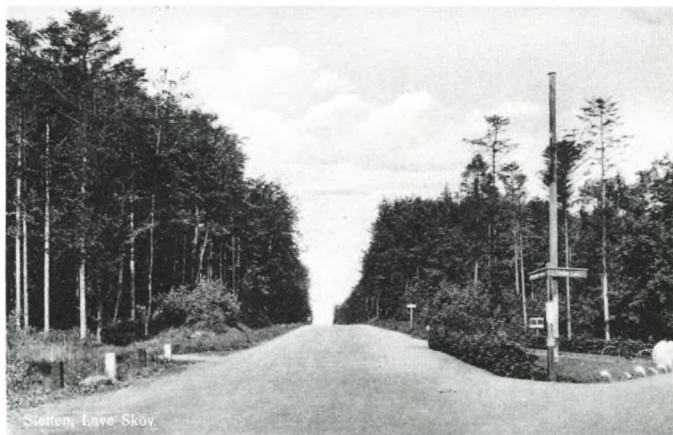
Hvor den nye vej tilsluttes Gl. Strandvej. Foto ca. 1930. På dette sted graves der en del af bakken gennem Lave skov, da forlængelsen af den nye vej føres over strandengene i 1946. "Vandstrandvejen"
