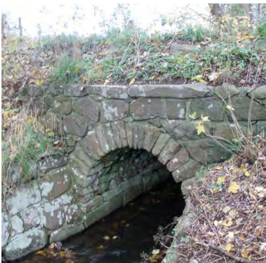
Fig. 3. Broens vestside. De såkaldte dosseringer på begge sider af broen har umuliggjort anbringelse af et stigbord her. Foto: jec.
