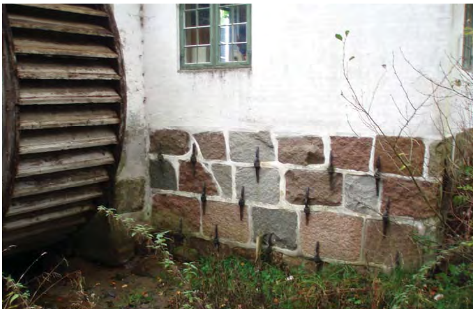
Fig. 6 Kvadre i Hammermøllens fundament. Foto: jec.
