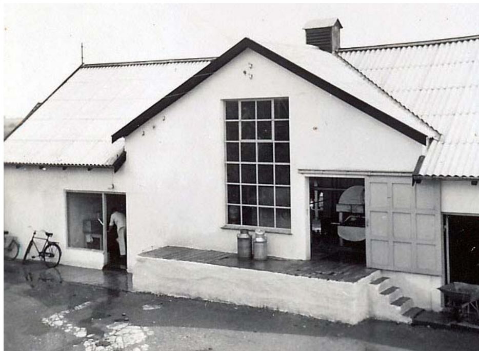
Mejeribygningen ved slutningen af 1950'erne med perronen til aflæsning af junger og indenfor den store vægt. T.v. for perronen var der et lille butikslokale.
