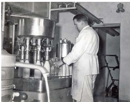
Flaskevaskemaskinen med betjening (th) og påfyldning flasker samt lukning med kapsler (tv).
