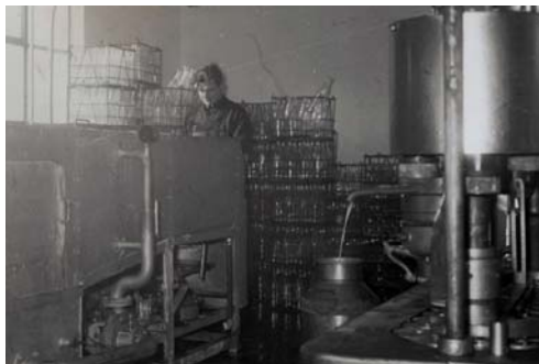
Flaskevaskemaskinen med betjening (th) og påfyldning flasker samt lukning med kapsler (tv).
