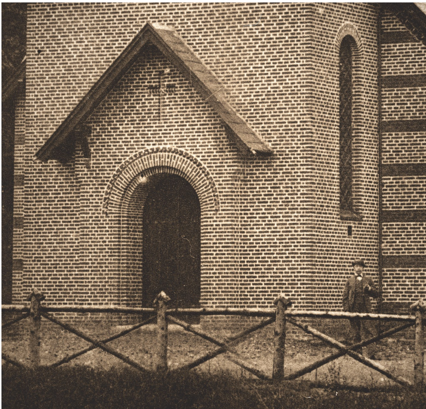
Arkitekt F.V. Tvede foran kirken umiddelbart efter byggeriets afslutning i 1868. (foto fra Danmarks Kunstbibliotek)
