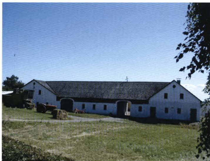
Nr. 21. Langstrupvej 14. Foto SAVE, 1999.
