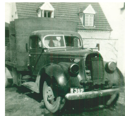
Fragtbilen ombygget til generator-kørsel under besættelsen
