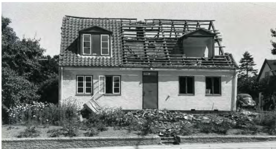
Banearbejderhuset, Benediktevej 1 i Fredensborg, under nedrivning i 1964. (Foto: Fredensborg Arkiverne)
